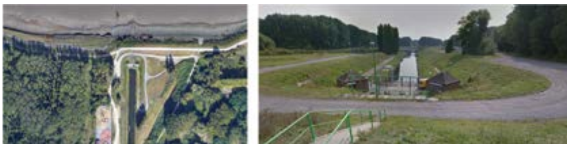
Figuur 2-3 Uitmonding Tophatgracht gelegen ten noordoosten van de 3M site
